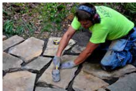
Kiveä hierretään kivituhkaa vasten ja lyödään kumivasaralla, jolloin kivituhka tiivistyy.
