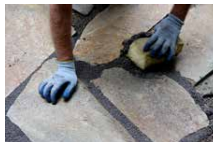
GftK-sauma kovettuu erittäin lujaksi.
